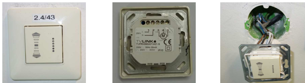
Obr.: Ovladač žaluzií – umístění na stěně, pohled na zadní stranu, pohled na kabeláž.
